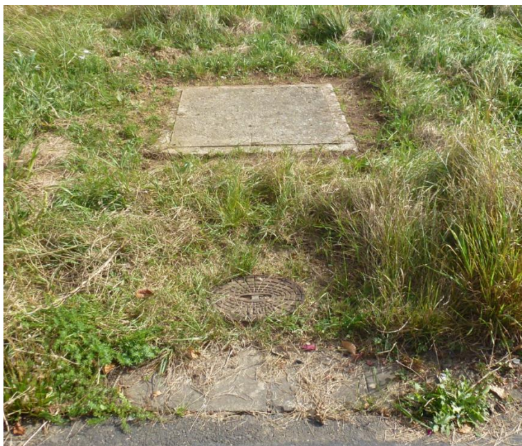
Schacht und Unterflurhydrant Bestandswasserleitung auf Vorhabengrundstück 8
